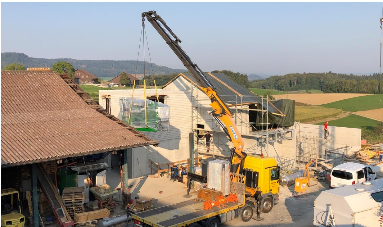
Einbau des Gasmotors des Blockheizkraftwerks der Holzvergasungsanlage Florian Gut, Desibach. (Bild: z.V.g.)
