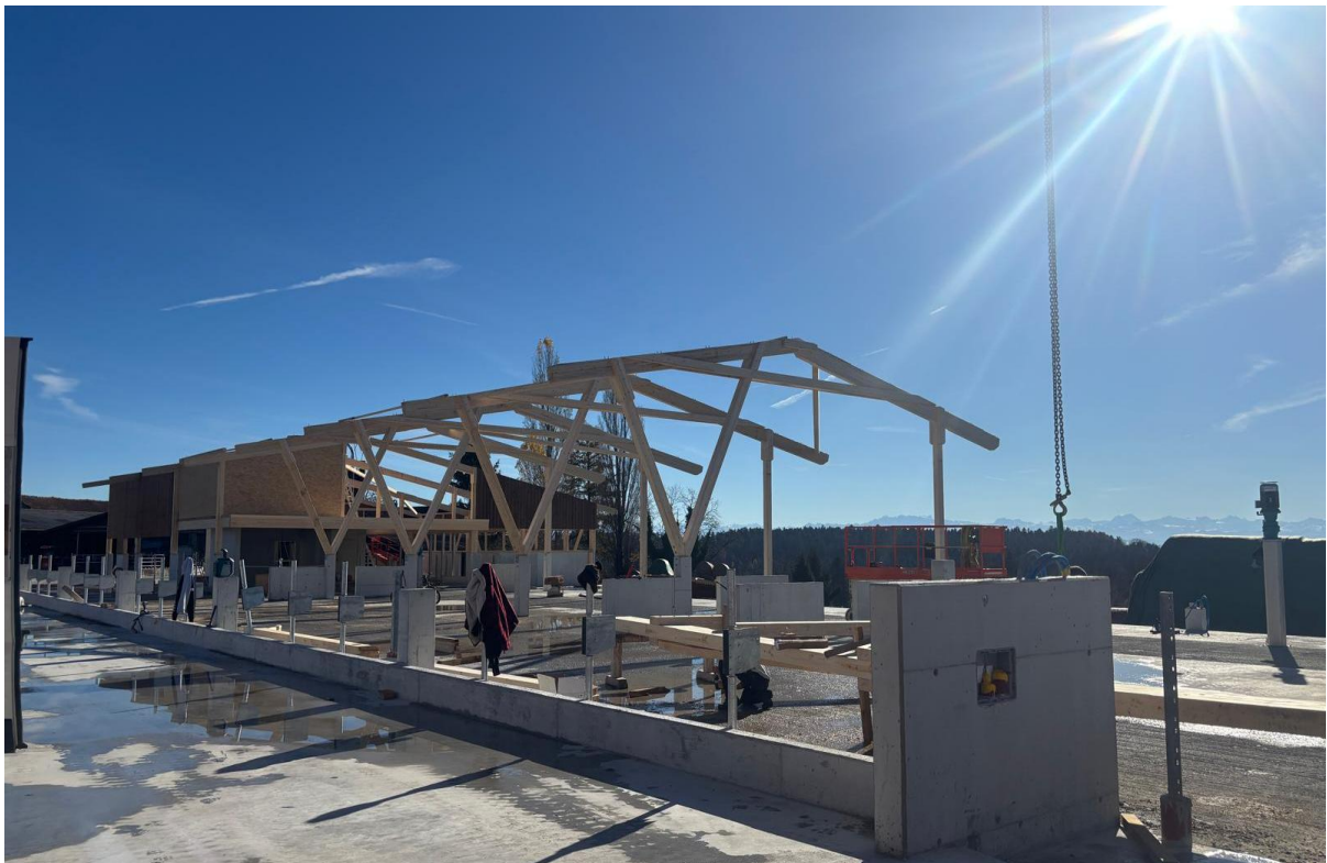
Der Bau geht voran. (Bild: Z.V.g., Gian Bucher, Oberembrach).
