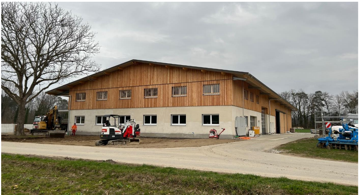
Moderne Verarbeitungs- und Lagerhalle der Spargelproduktion kurz vor der Fertigstellung. (Bild: Z.V.g., GG Spaltenstein Rolf & Joel, Flaach)
