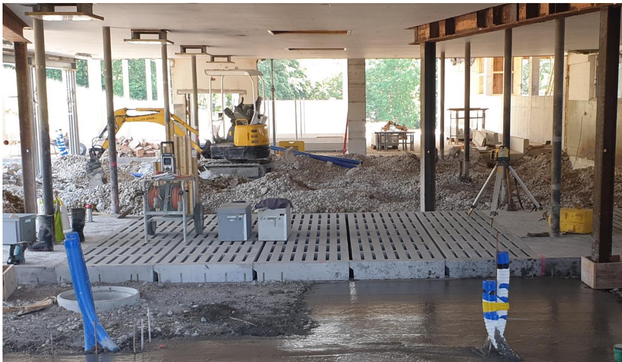
Umbauarbeiten benötigen eine detaillierte Planung und Koordination. (Bild: Z.V.g., Reto Bieri, Turbenthal)
