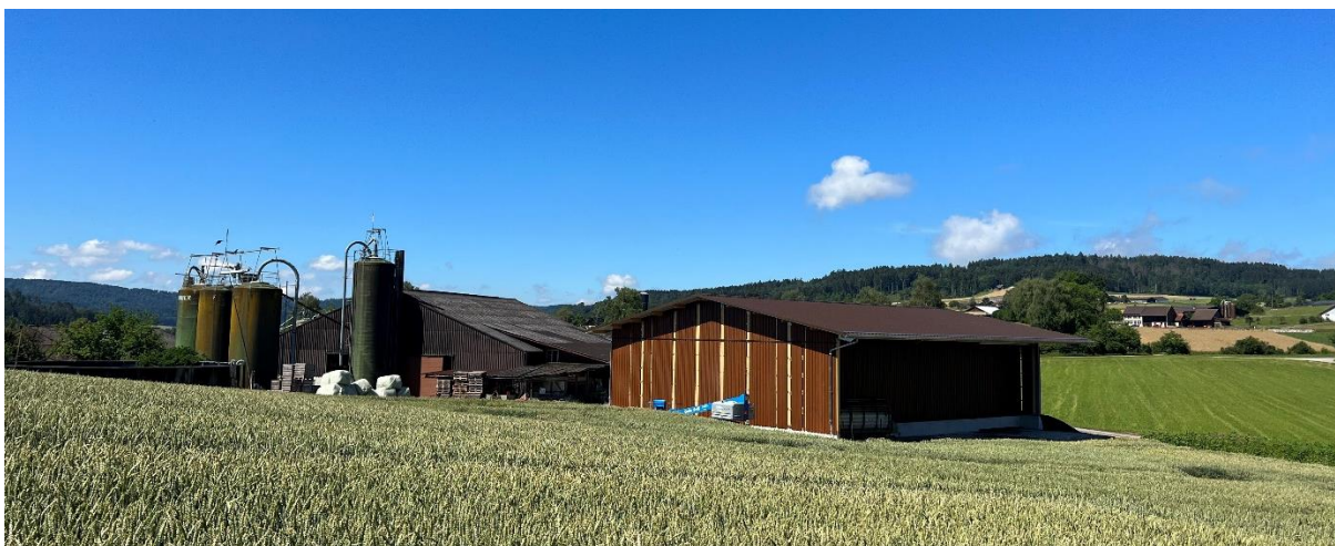
Schön gestaltete Remise mit einem Spritzenwaschplatz (Förderung ökologische Massnahmen gem. SVV). Bild:(z. V.g., Ch. Frei, Aesch)
