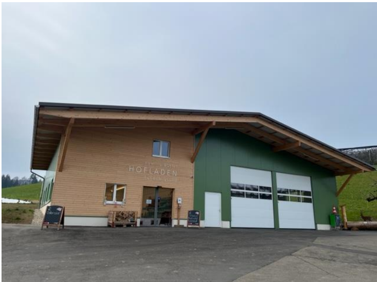
Gelungenes Bauprojekt einer Obstlager- und verarbeitungshalle mit dazugehörigem Hofladen. Bild: Z.V.g.
